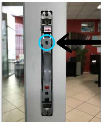
A l'aide d'une clé Allen de 3, dévisser la vis de deux trois tours (ça va libérer le crochet), à l'aide de l'autre main avancer ou reculer le crochet afin de régler le jeu, et revisser la vis fermement pour pouvoir le rebloquer.
