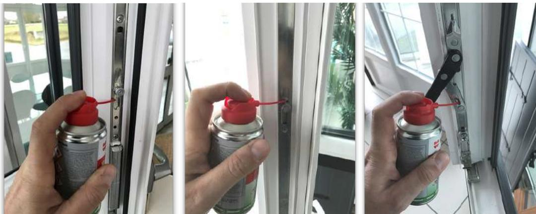
Afin de garantir la souplesse du mouvement des ferrures, les gâches doivent être lubrifiées une fois par an.
