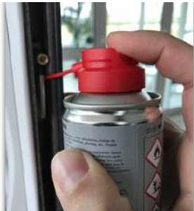
Sur les coulissants il est important de lubrifier à l'intérieur du verrou au niveau du crochet de fermeture.
